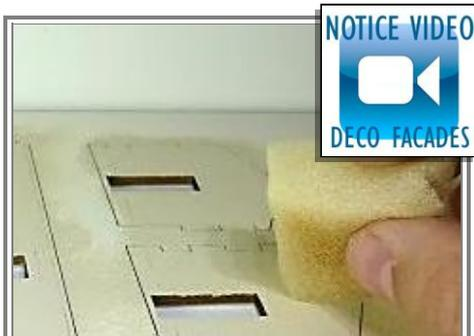
**1** Sans détacher les éléments de la planche de façades, commencer par simuler le crépi avec une éponge mousse. Vérifier que les gravures se trouvent côté extérieur du bâtiment. Attention à ne pas réaliser un grain qui ferait grossier.
