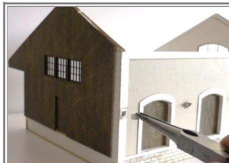
Après peinture dans le même coloris que les parements, mettre en place les supports de charpente en les maintenant le temps de la prise. Faire de même avec les bois de charpente.
