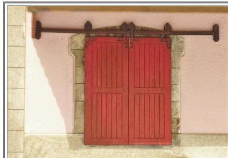
**9** Après peinture des portes et des coulisses métalliques, mettre en place les portes de halle par l'extérieur.
