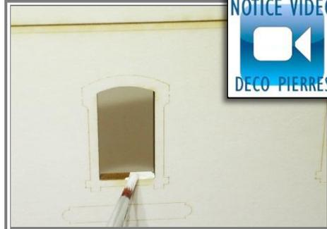
**3** Peindre les voûtes et appuis de fenêtres qui ne seront pas recouverts par le carton des parements. Mettre également en peinture les pierres de sous-bassement.
